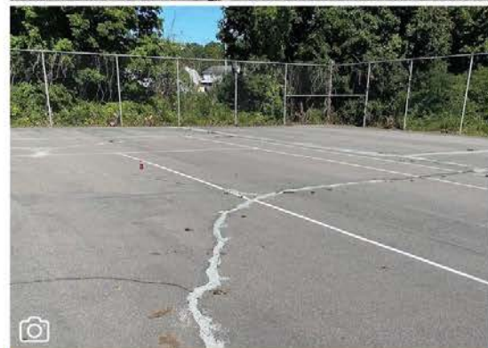
Antes y después: Reparación del asfalto en el Centro de Transición de New Britain.
